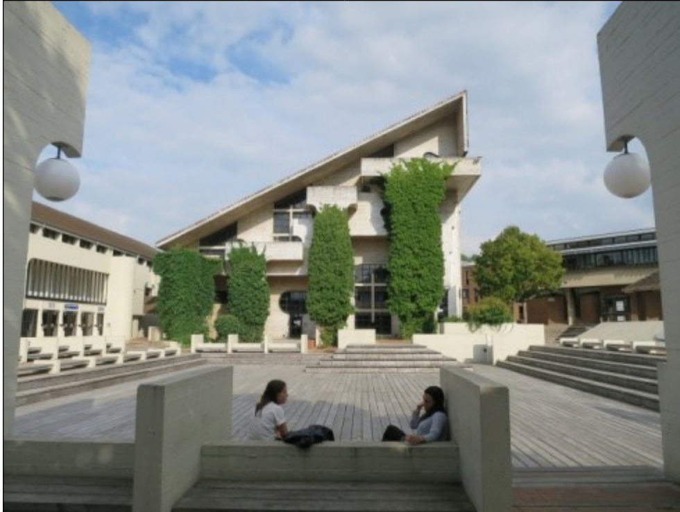
Fig. 8. Het plein voor de wetenschapsbibliotheek (Place des Sciences). Deze piazza van beton en hout is de belangrijkste ontmoetingsplaats van de eerste fase. Het omvat toegang tot de onderdoorgang voor auto's en een ondergrondse parkeergarage. Foto van de auteur, genomen in 2015.
