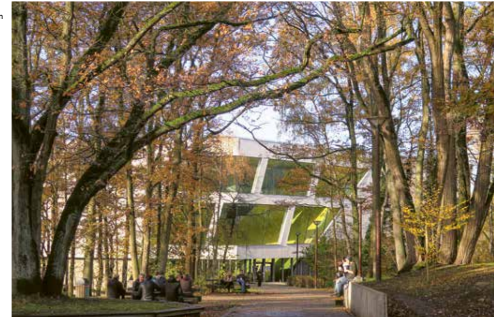
Musée Hergé, vom Bahnhof aus gesehen, Architekt: Christian de Portzamparc
