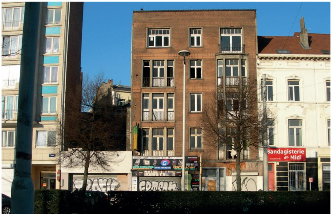
A côté de l'immeuble construit place Bara sur le lit de la Senne, un garage, ancienne propriété de l'Etat, permettant d'accéder au lit de la rivière, devant être détruit et l'immeuble mitoyen abandonné devant être repris en sous œuvre et rénové.
