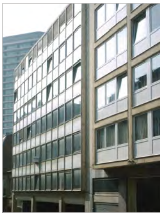
Curtain wall façade before transformation work. Source : Bureau d'Architectes Emmanuel Bouffieux.
