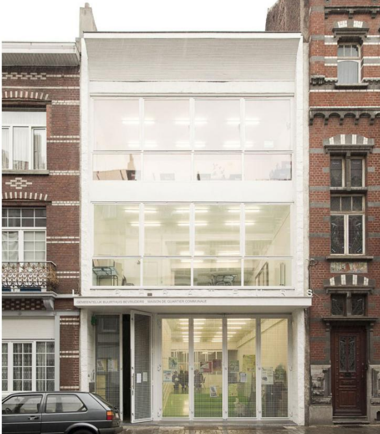
Contrat de Quartier Escaut-Meuse Architecture : B-architecten Photo : Jeroen Verrecht
