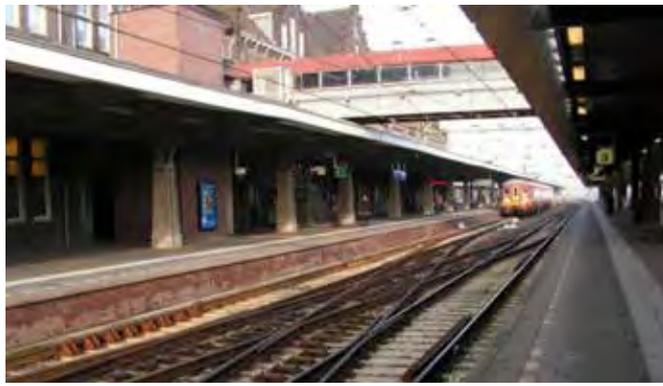
Figure 10 : Une piste de réflexion pour Bruxelles-Midi consiste à insérer au milieu de certaines voies à quais existantes des appareils de voie supplémentaires. Cela permet de pouvoir recevoir sur un quai (long) deux trains Z (courts). Cette solution pragmatique pour augmenter la capacité des terminus se rencontre très fréquemment aux Pays-Bas, comme ici en gare de Maastricht. Technum
